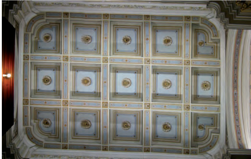
Fig. 2.23 – Solaio cassettonato di copertura dell'aula della Chiesa.
