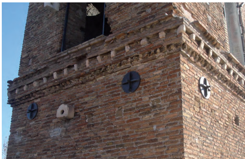
Fig. 4.25 – Capochiave della catena inserita sul campanile.
