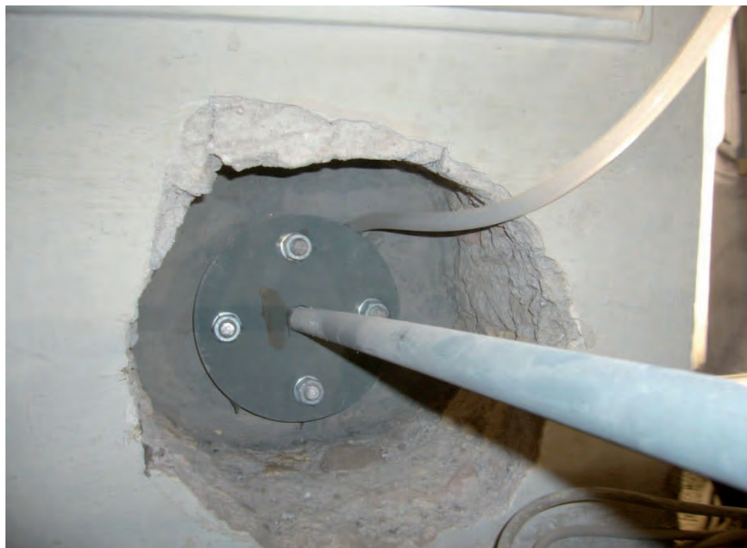
Fig. 4.21 – Scasso nella muratura per l'inserimento della piastra di ancoraggio della catena.
