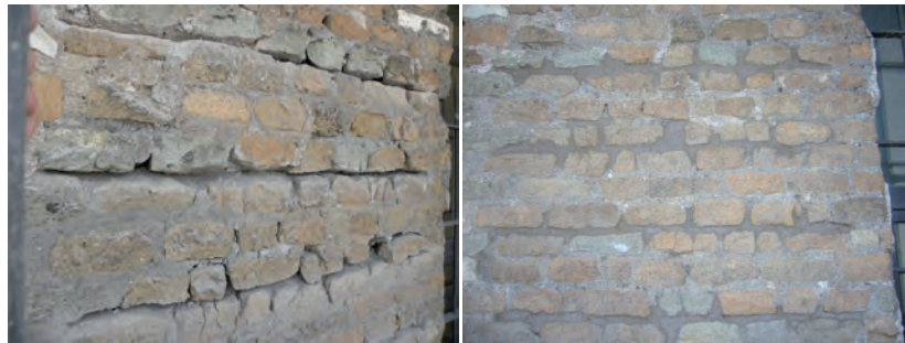
Fig. 4.30a – Scarnitura delle fughe. Fig. 4.30b – Stuccatura delle fughe dopo l'inserimento delle barre.
