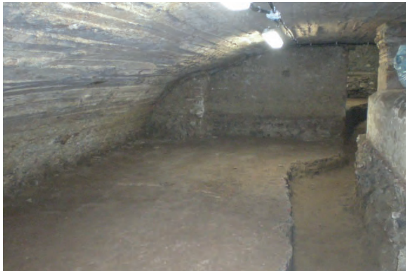
Fig. 2.44 – Fotografia del locale seminterrato sottostante l'aula principale. Anche in questo caso è possibile osservare la volta a botte di copertura del locale e le zoccolature realizzate con materiale diverso rispetto alle murature.
