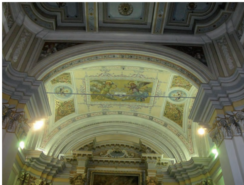
Fig. 4.23 – Immagine dell'arco trionfale allo stato attuale; è possibile osservare la nuova catena.
