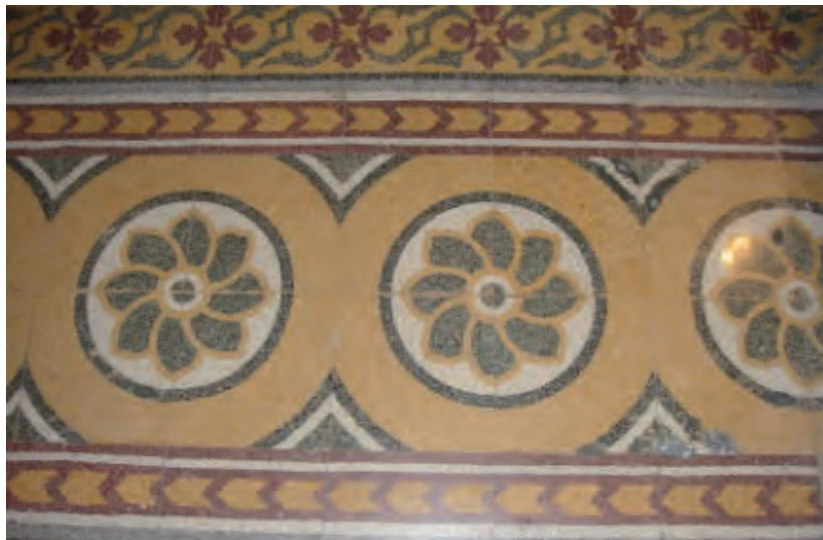
Fig. 5.06 – Stilatura delle fughe della pavimentazione.
