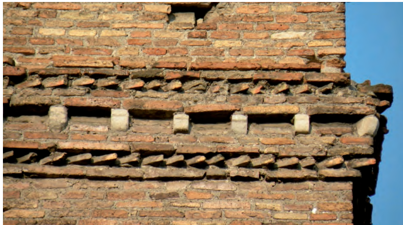
Fig. 2.40 – Dettaglio e di una delle cornici marcapiano.
