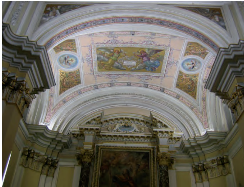
Fig. 2.24 – Volta a vela a copertura del presbiterio.
