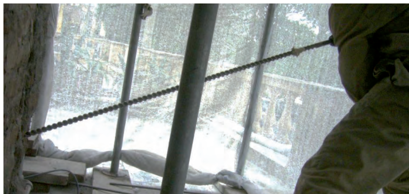
Fig. 4.32 – Pre-foratura diagonale della muratura per la posa in opera delle barre in fibra di basalto.
