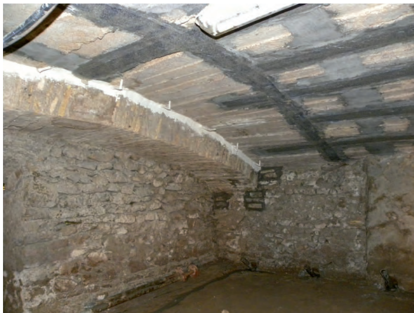
Fig. 4.17 – Interventi sull'arco del seminterrato: iniezione di collegamento e ripristino dell'appoggio.
