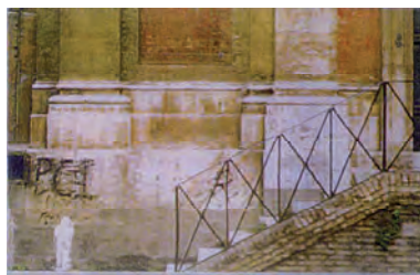
Fig. 2.51 – Foto della scalinata a sinistra del portone prima del restauro del 2000.
