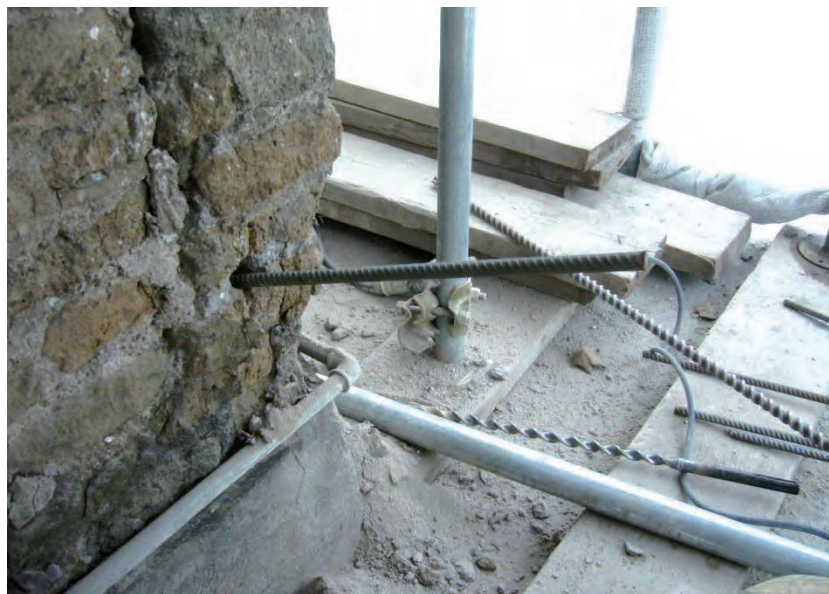
Fig. 4.33 – Inserimento delle barre in fibra di basalto diagonalmente sulle angolate del campanile.
