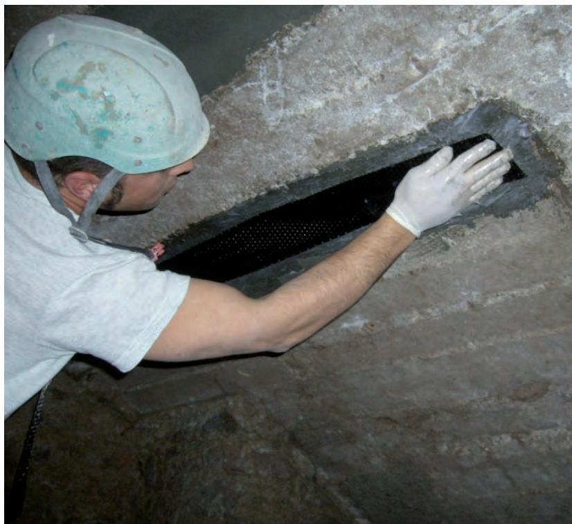
Fig. 4.15 – Posa in opera delle Fasce in FRP tramite l'utilizzo di adesivo tixotropico.
