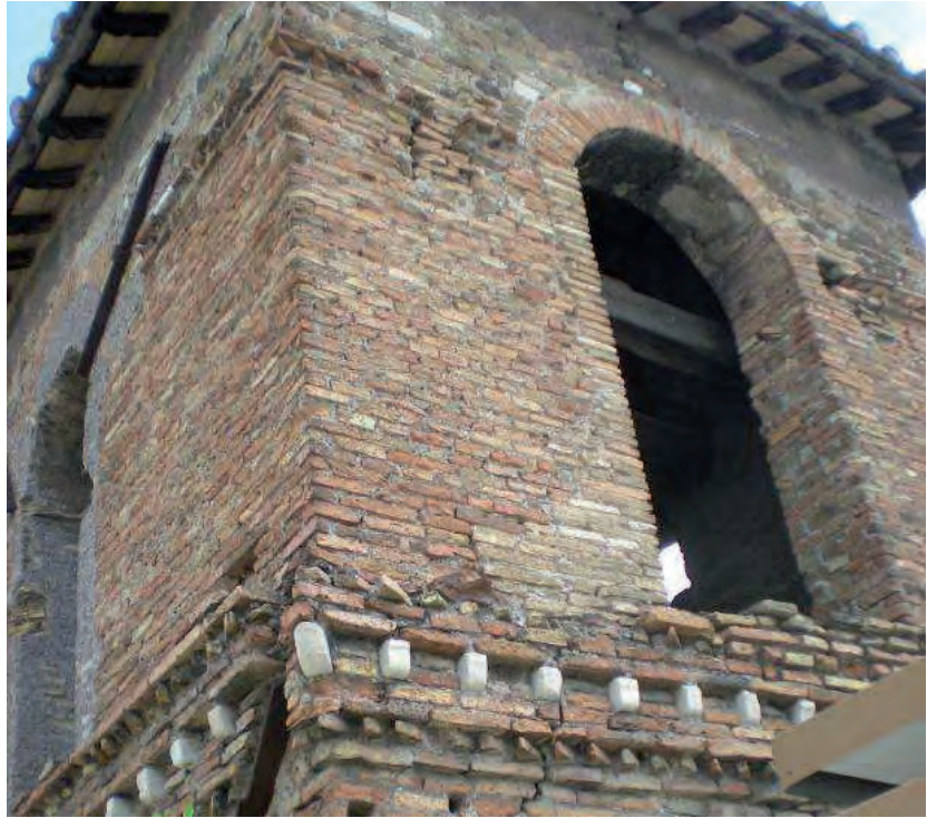
Fig. 3.11 – Immagine del quadro fessurativo del prospetto Nord riportato in Fig. 3.09.
