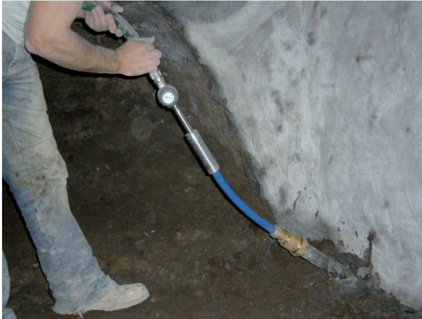
Fig. 4.11 – Riempimento del foro con malta cementizia ad altissima pressione per lo sbulbo delle teste dei pali.
