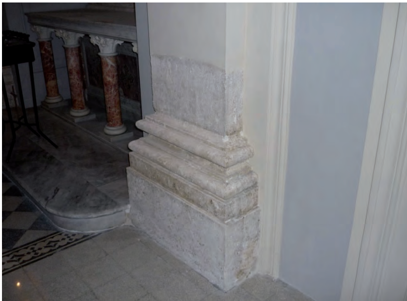
Fig. 5.05 – Dettaglio del basamento delle paraste. Si è scelto di non tinteggiare, ma di ripulire e di lasciare a vista il materiale originario.
