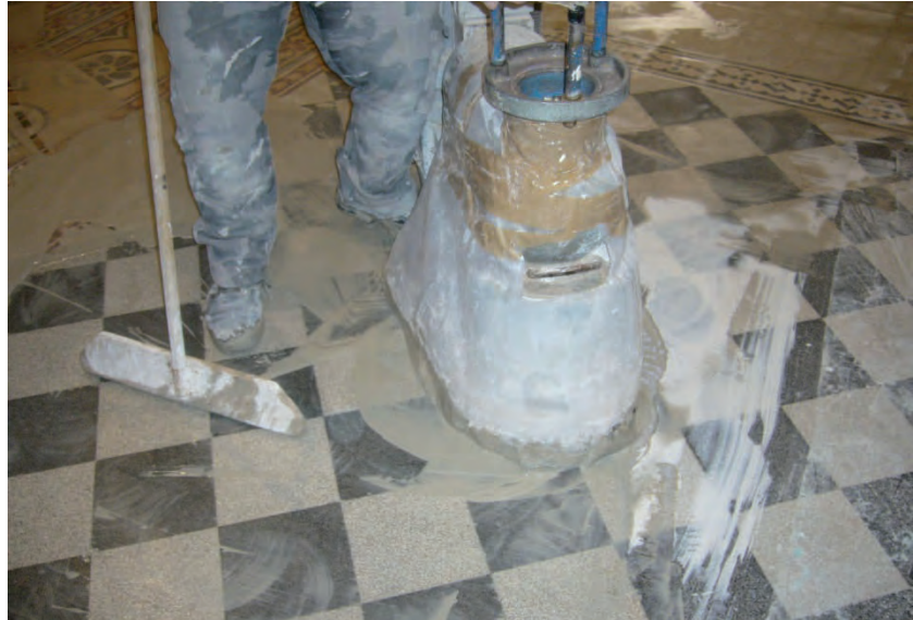
Fig. 5.07 – Pulizia del pavimento dell'aula della Chiesa con mezzo meccanico.
