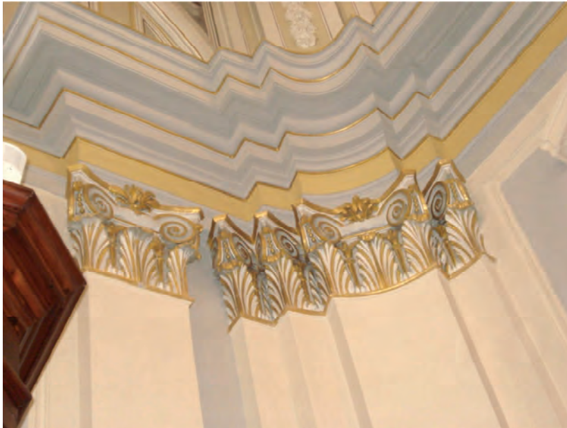
Fig. 5.04 – Dettaglio delle finiture in oro dei capitelli e delle cornici.
