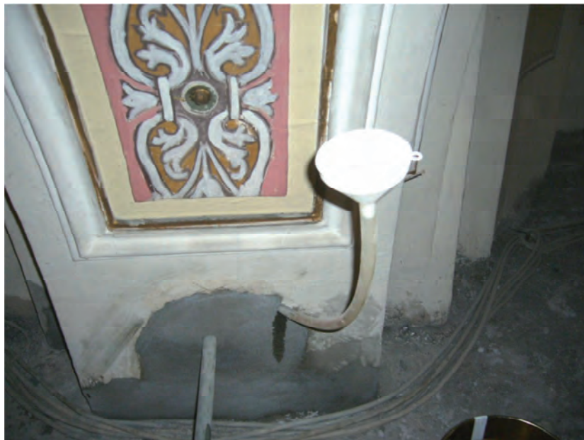
Fig. 4.22 – Ripristino del paramento murario e colaggio di resine epossidiche fluide.
