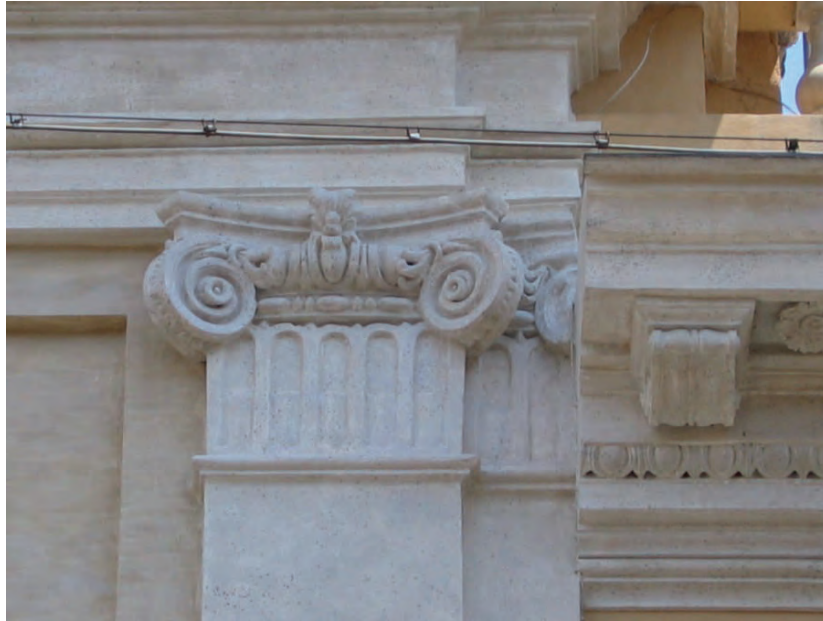
Fig. 2.57 – Capitello del secondo ordine di facciata, si nota come il capitello della controparasta sia stato tagliato per far posto al cornicione dell'adiacente monastero.
