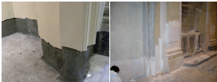
Fig. 5.02a – Rifacimento dell'intonaco eliminato.
