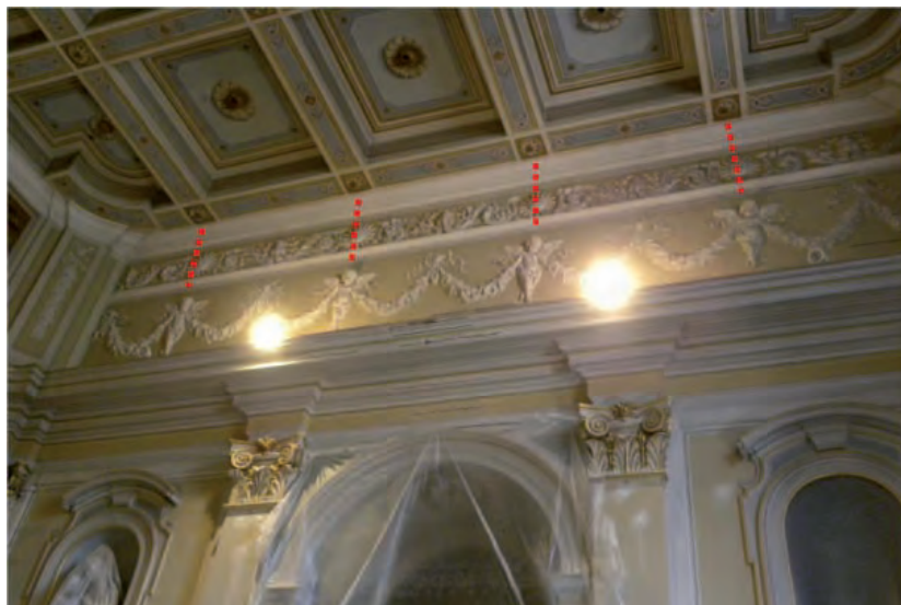
Fig. 2.27 – Corrispondenza tra la decorazione del fregio e il solaio cassettonato.
