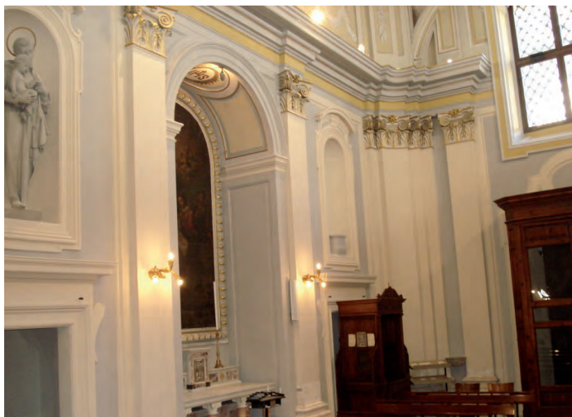
Fig. 5.03 – Tinteggiatura interna bicolore delle murature.
