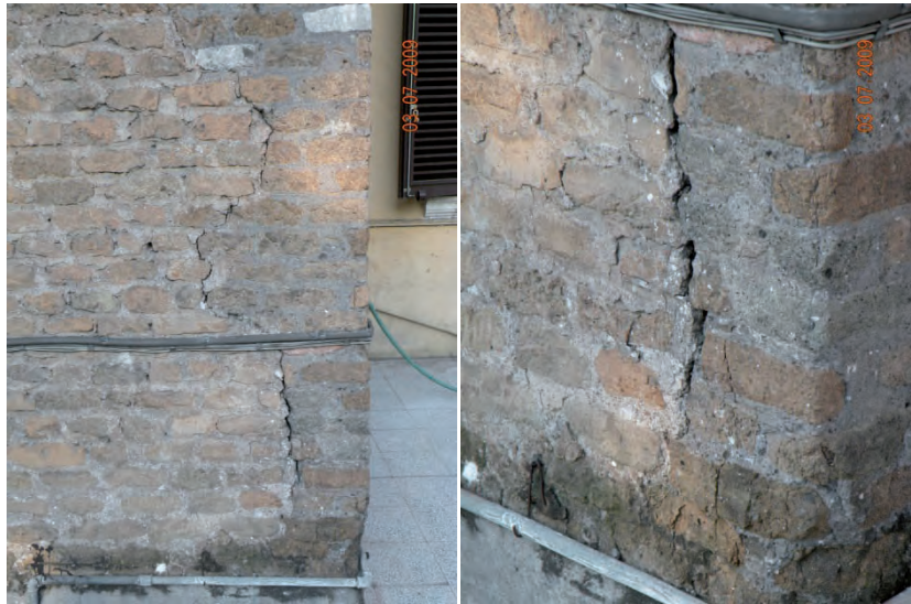
Fig. 3.13a – Fessura longitudinale passante sul campanile che coinvolge l'angolata.
