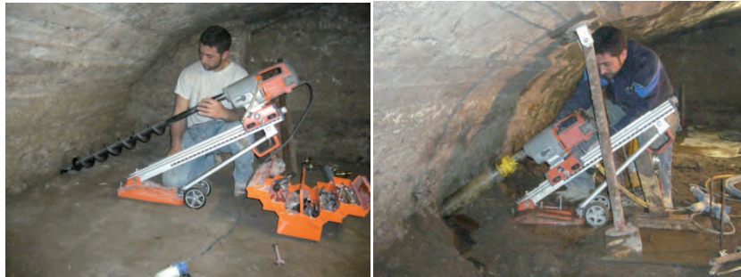
Fig. 4.9b – Perforazione del terreno per la realizzazione dei micropali.
