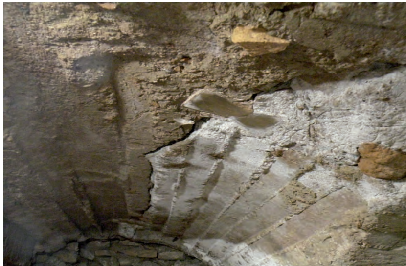
Fig. 3.03 – Immagine di una delle fessure longitudinali alla volta nella quale è possibile individuare il disassamento dei due lembi della fessura.
