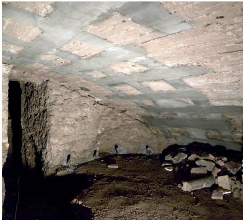
Fig. 4.14 – Realizzazione dello strato di fondo in malta tixotropica.
