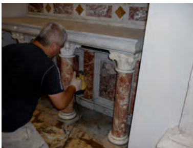
Fig. 5.09 – Pulizia degli elementi marmorei con spray d'acqua a getto di vapore.
