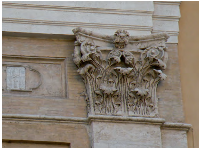
Fig. 2.56 – Capitello corinzio del primo ordine di facciata, si nota come il capitello della controparasta sia stato eliminato per creare la continuità tra la facciata e le murature del convento adiacente.
