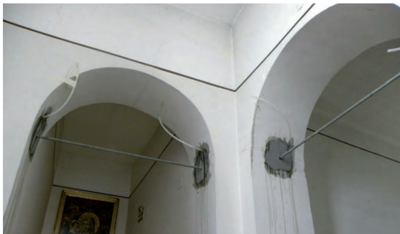
Fig. 4.26 – Posizionamento delle catene sulle pareti del campanile inglobate nel complesso monastico.
